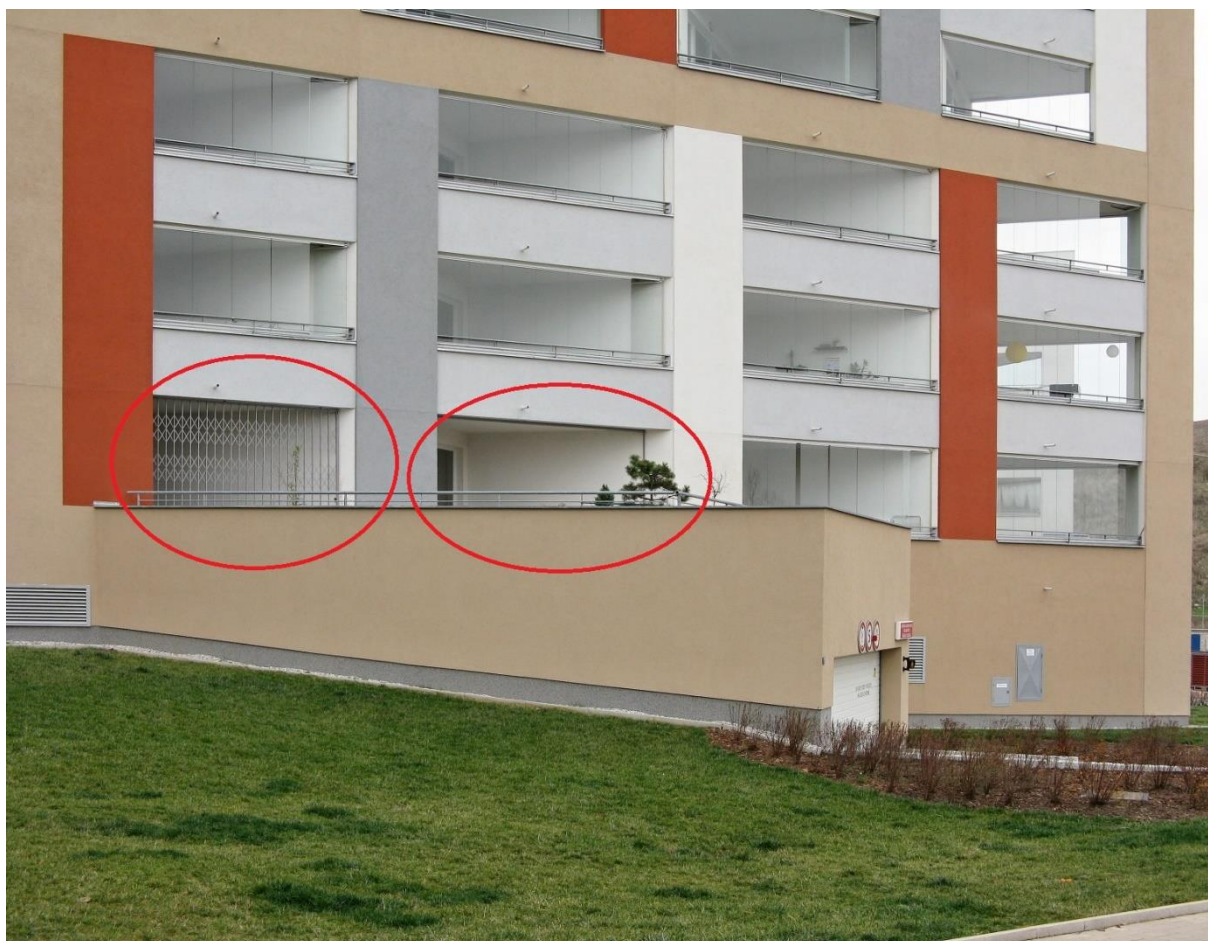
Bezpečnostní mříž, byt 201.
